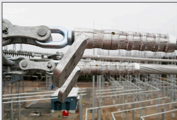
Seulement quatre passes Swage requises sur les terminaisons de lignes AAC à plaque unique
